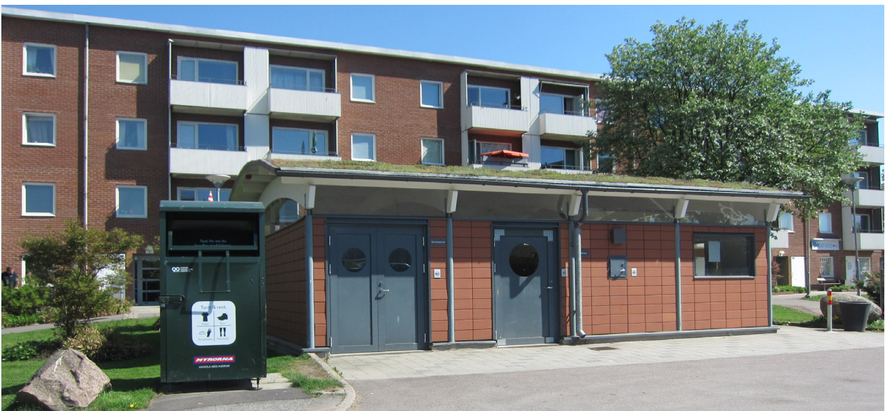
Avfallsutrymmens placering behöver nogra övervägas för att skapa en trygg och ändamålsenlig avfallshantering. FOTO: DAVID ALTHOFF PALM, RAMBOLL.
